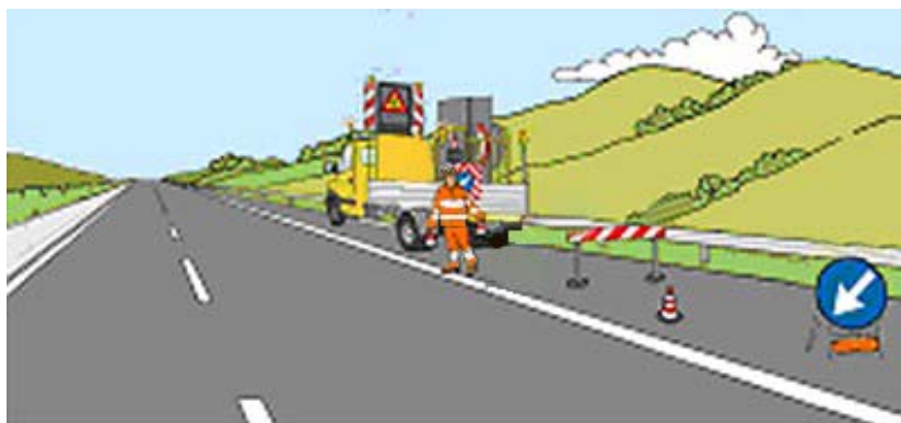
Figura 19 – Chiusura della corsia di emergenza: installazione della testata di chiusura
