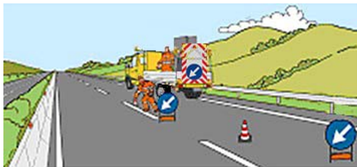
Figura 39 – Chiusura della corsia di marcia: inizio della posa dei coni
