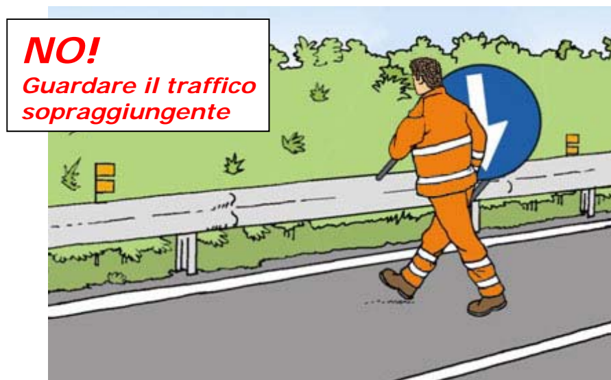
Figura 17 – Trasporto manuale della segnaletica
