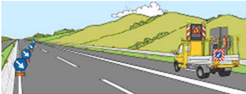
Figura 32 – Chiusura della corsia di sorpasso: installazione della testata di esclusione della corsia
