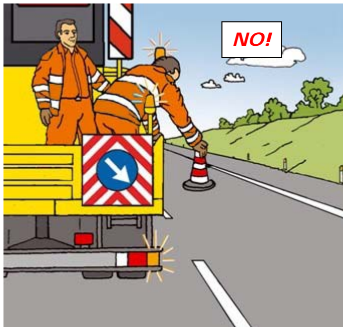
Figura 46 – Posizionamento dei cono o de.fle.co.: comportamento scorretto
