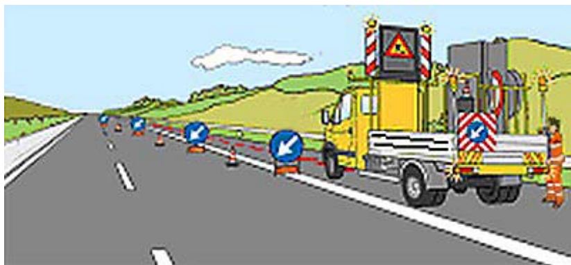
Figura 25 – Chiusura della corsia di marcia: installazione della testata di esclusione della corsia
