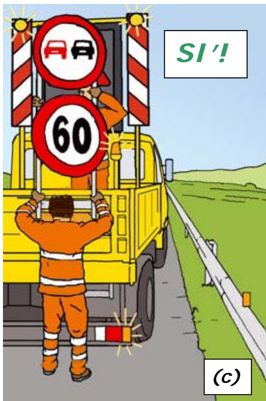
Figura 15 – Prelevamento della segnaletica da automezzo: comportamenti corretti (a), (c) e scorretti (b), (d)
