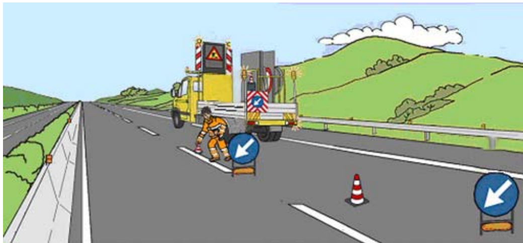
Figura 26 – Chiusura della corsia di marcia: inizio della posa dei con
